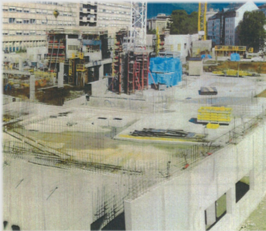
Figure 1 Le projet au début du chantier.
