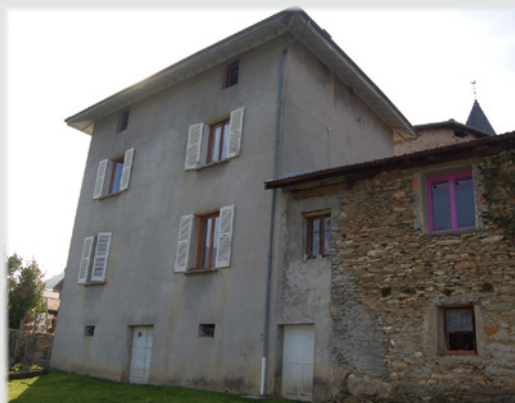
Figure 1 La bâtisse, la façade arrière.
