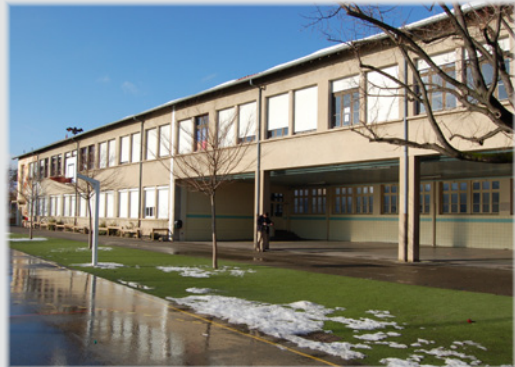
Figure 2 Le groupe scolaire Ambroize-Croizat près de Lyon, la façade principale sur la cour.
