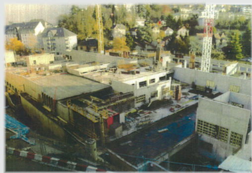
Figure 2 Le projet à un état plus avancé, sous un autre angle.
